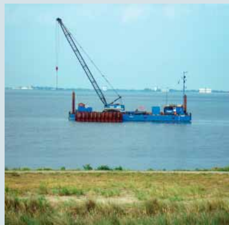
Parallel zu den Arbeiten auf der Startseite wurde das Einleitbauwerk mit der genau zu treffenden Zielöffnung gebaut.
