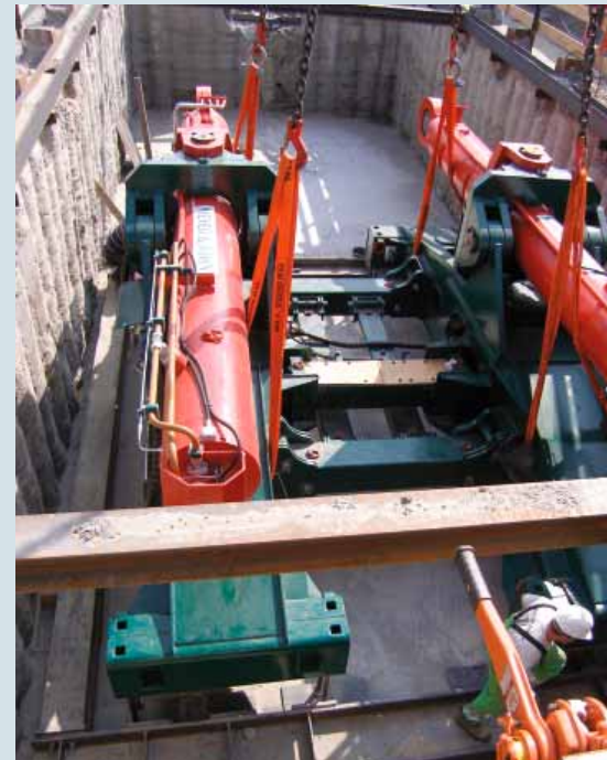
Montage des Pipe Thrusters in der Startbaugrube.
