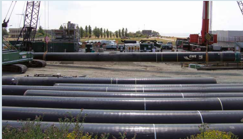
Der Rohrstrang war in Sektionen von 36 Metern Länge unterteilt.
