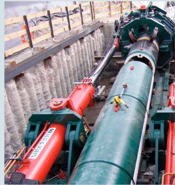
Die beweglich gelagerten Nachläuferrohre erleichtern genaues
